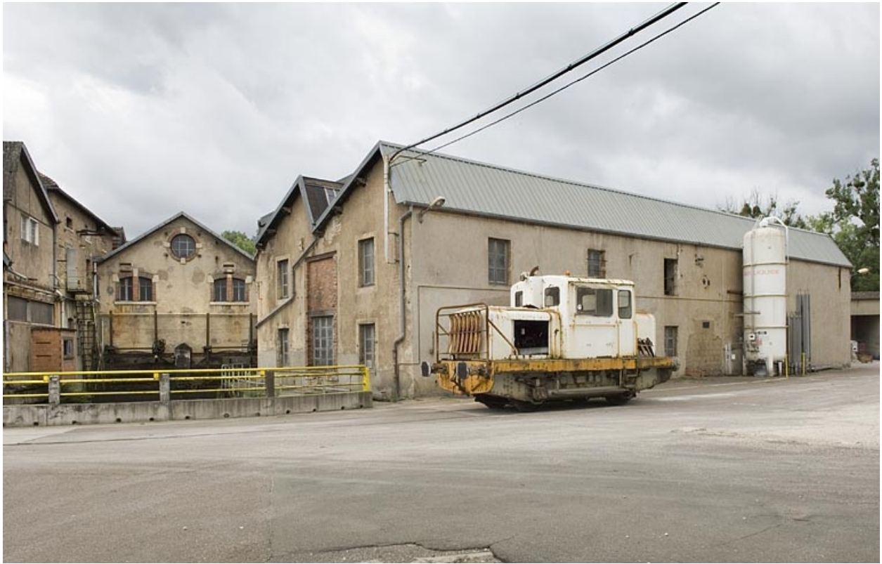
Bâtiment d'eau et atelier couvert de sheds.
