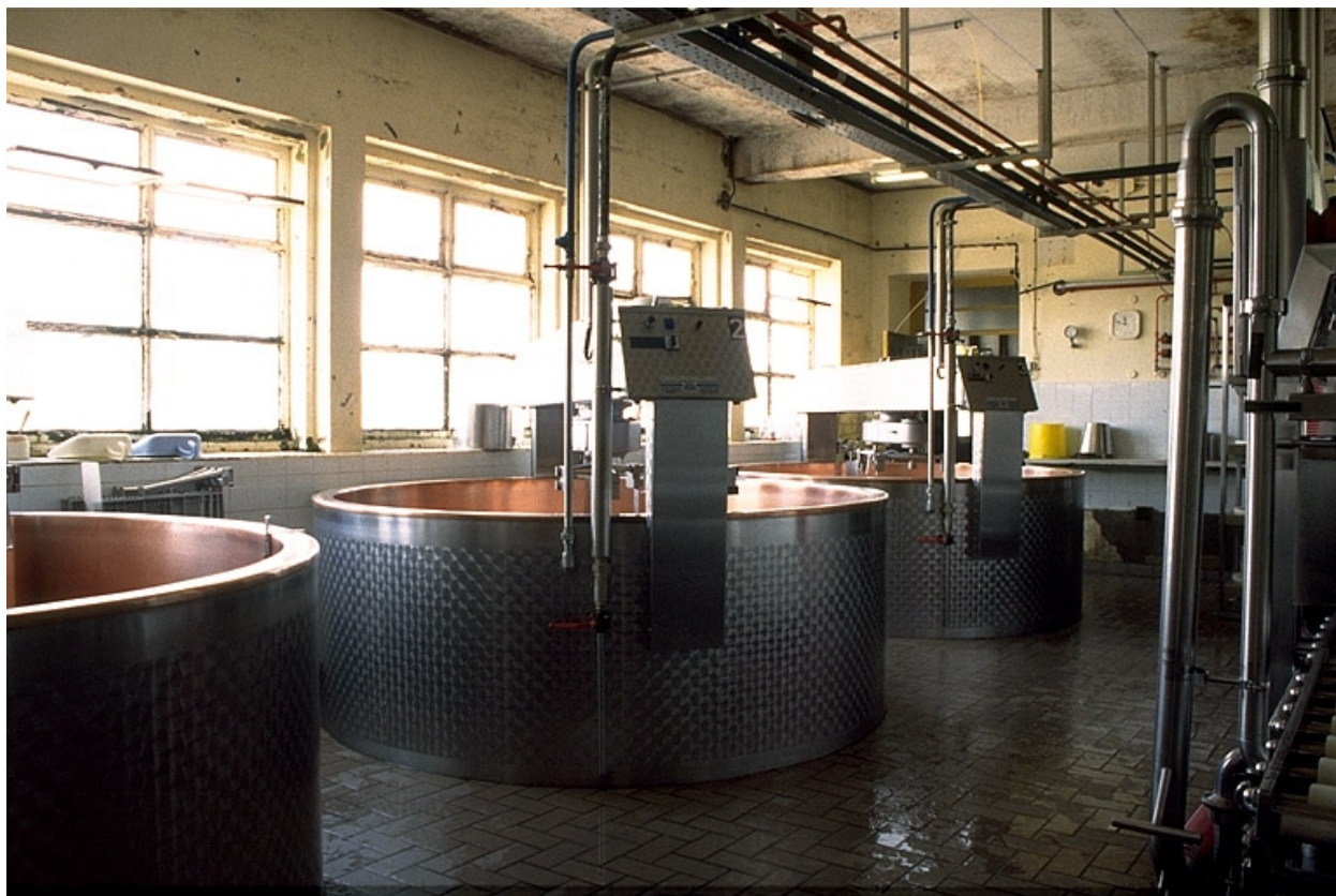
Cuves Chalon Mégard.
