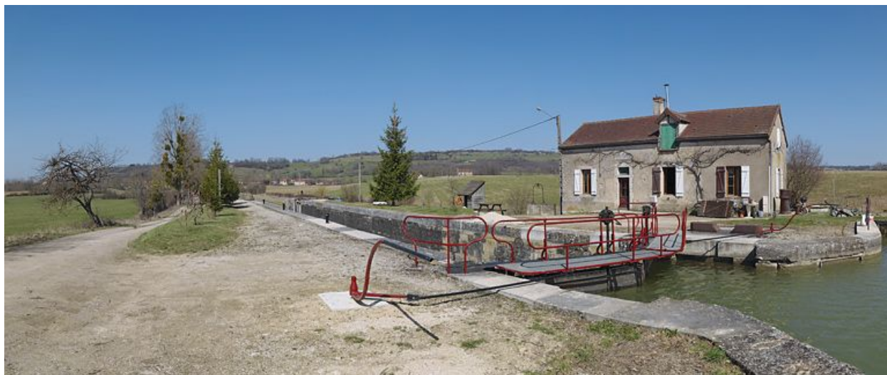
Le site d'écluse vu d'amont.
