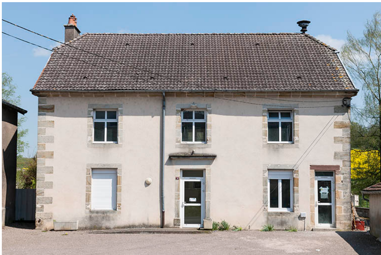
La façade principale.
