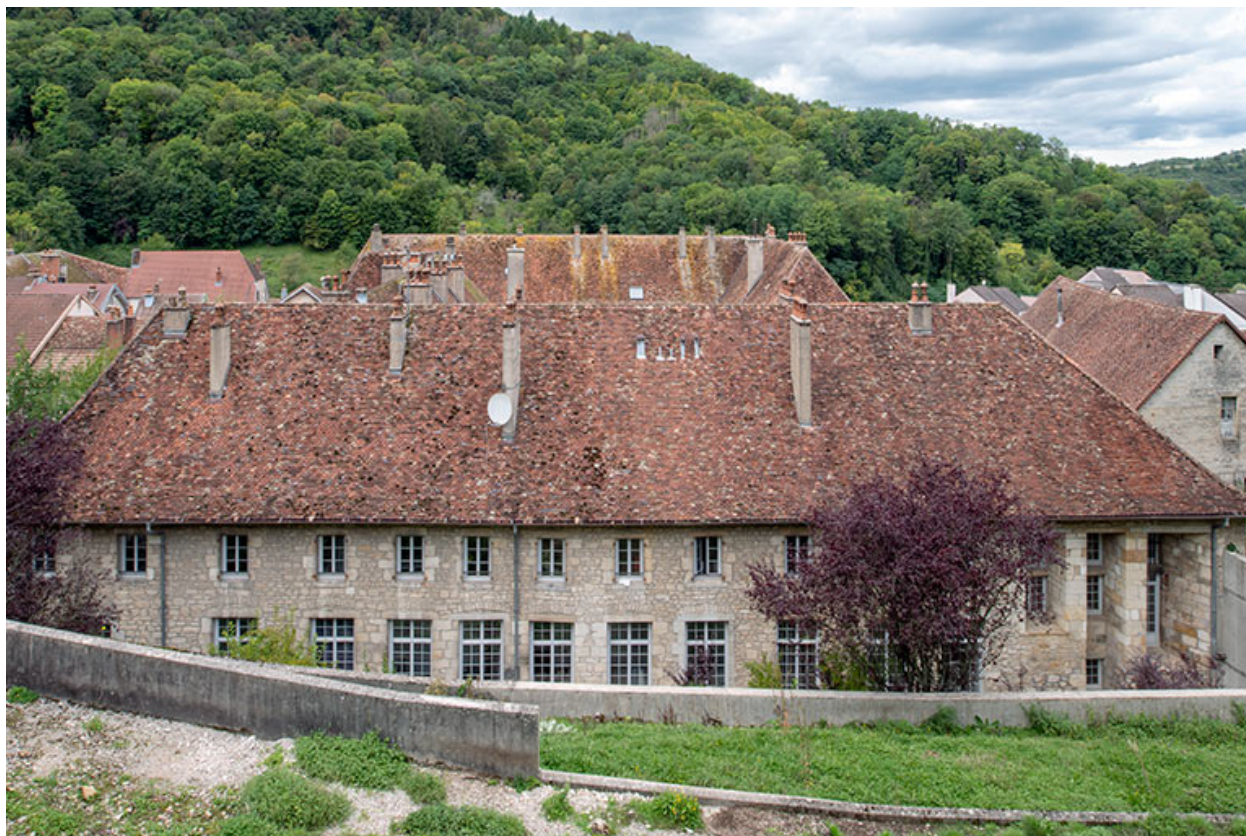
Bâtiment amont. Façade est.
