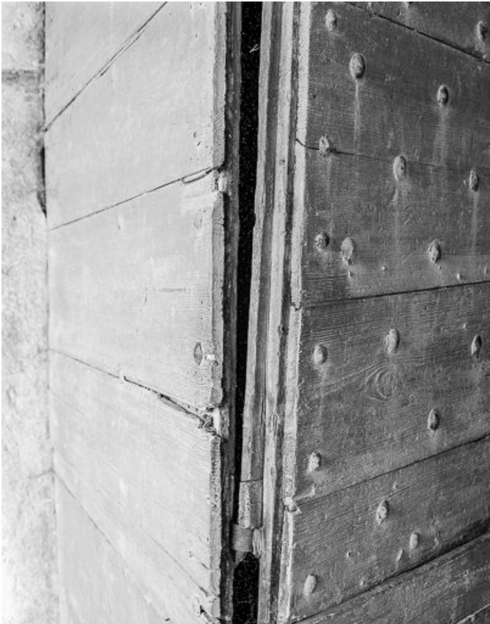
Porte piétonne de la porte de grange.
