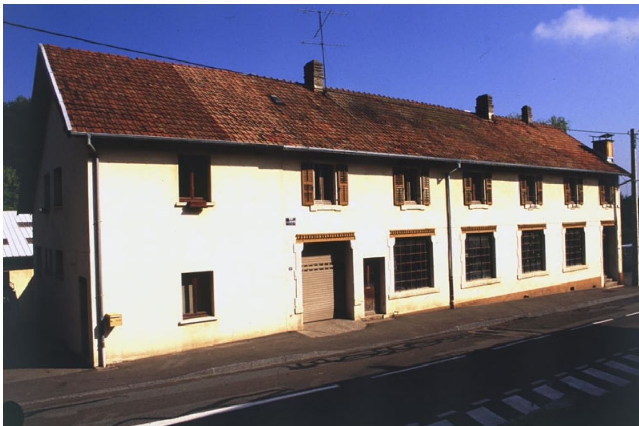
Façade sur rue de l'atelier de fabrication.
