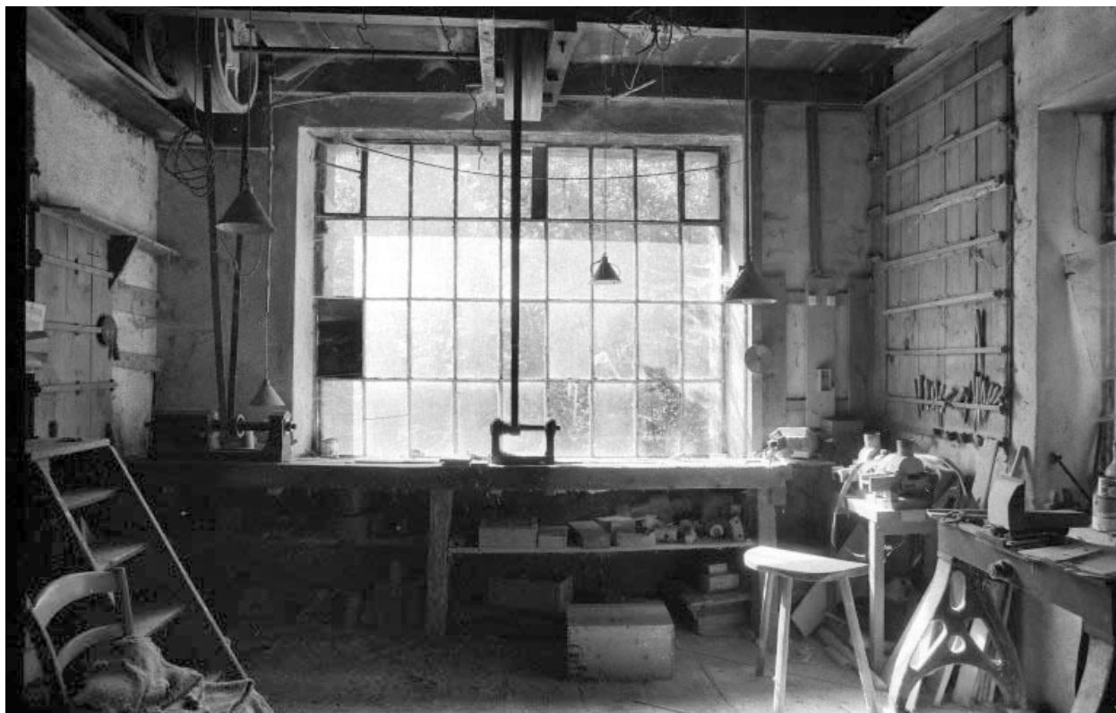
Intérieur d'un atelier de fabrication (bâtiment E).
