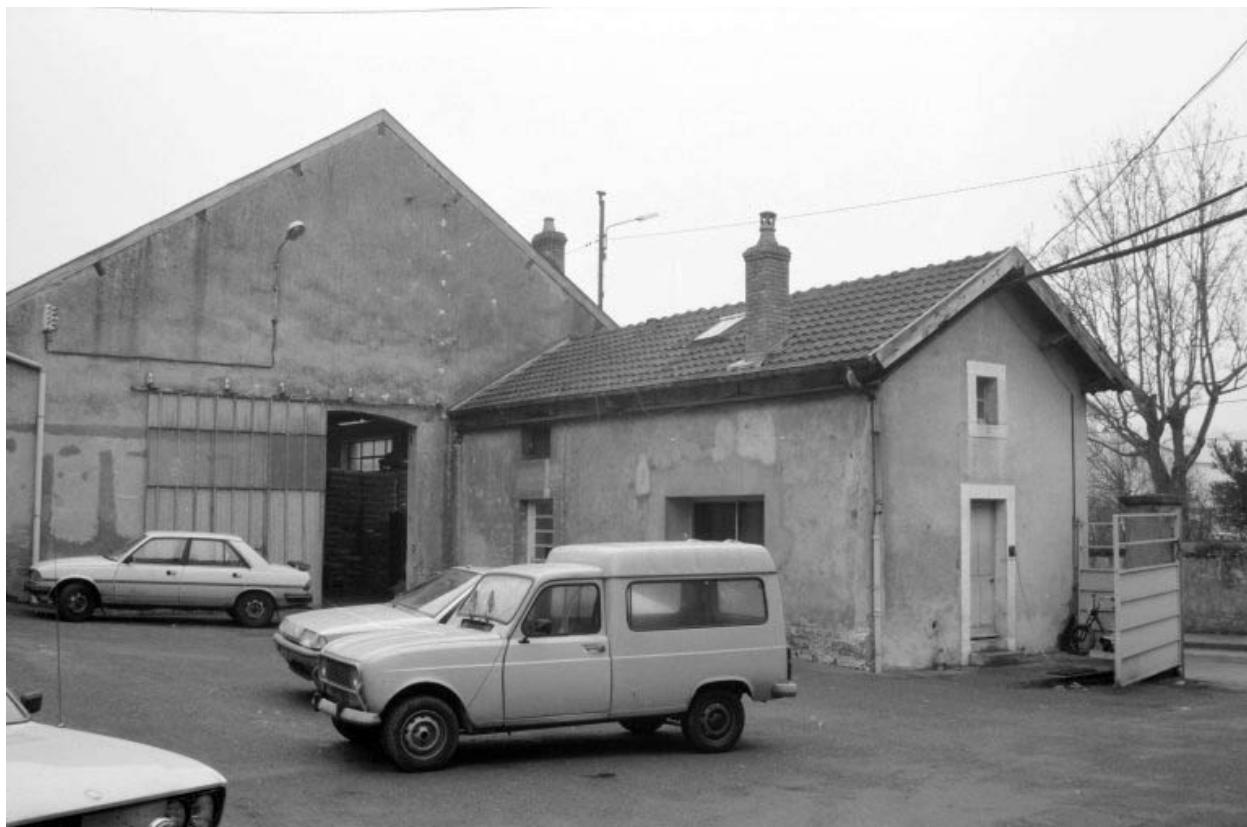
Entrée, cantine et entrepôt (8) vus de l'est.
