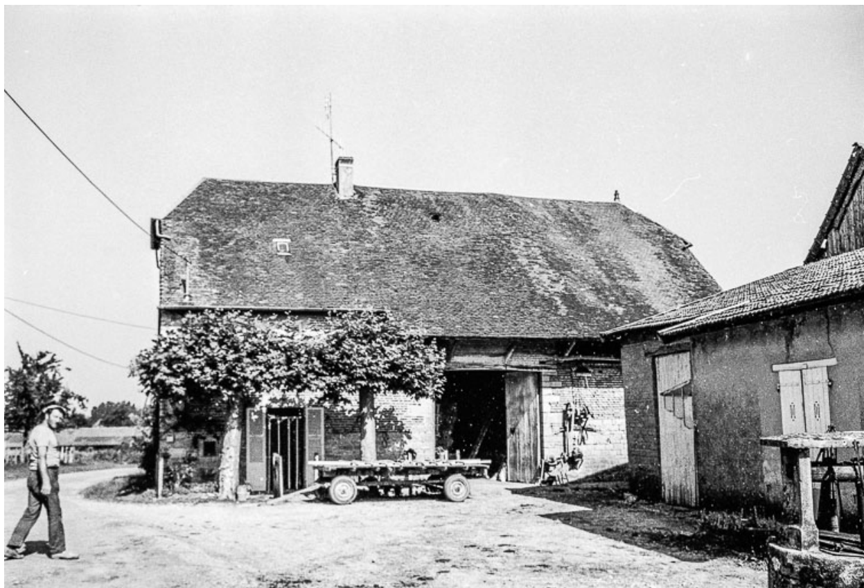
Ferme du 19e siècle cadastrée 1811 D2 : vue générale.
