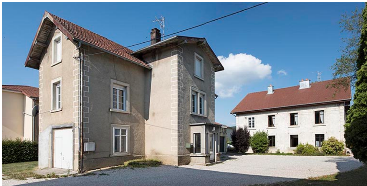
Logement de contremaître et maison, depuis l'est.
