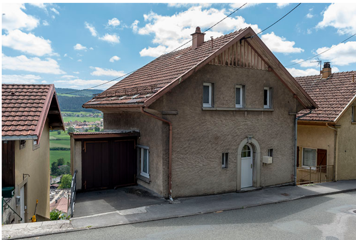
Façades antérieure et latérale gauche.
