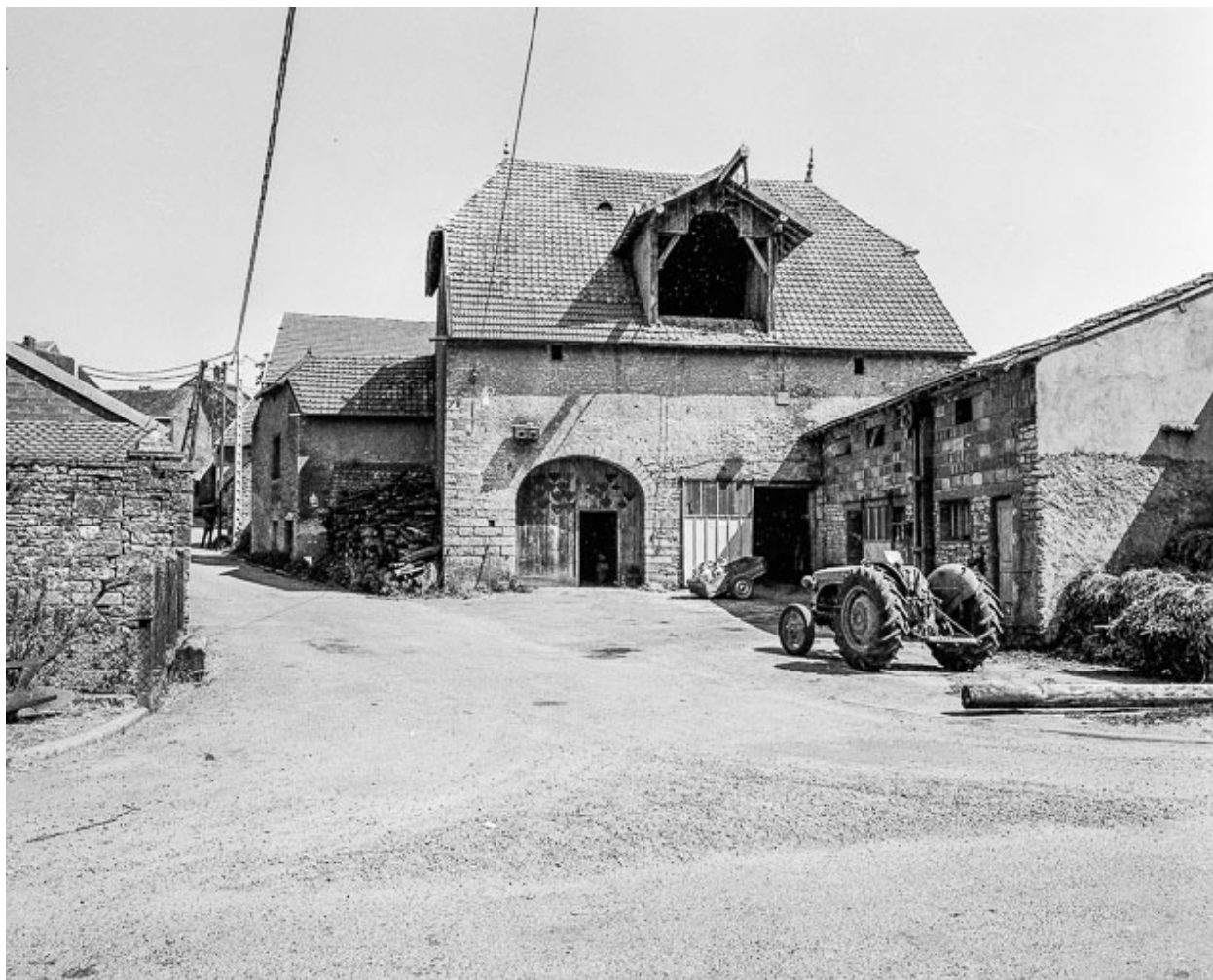
Fermes situées rue de la Traverse à Chenevrey.
