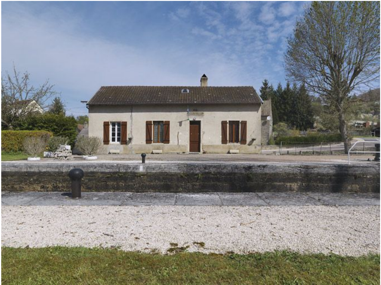
Maison éclusière de face.
