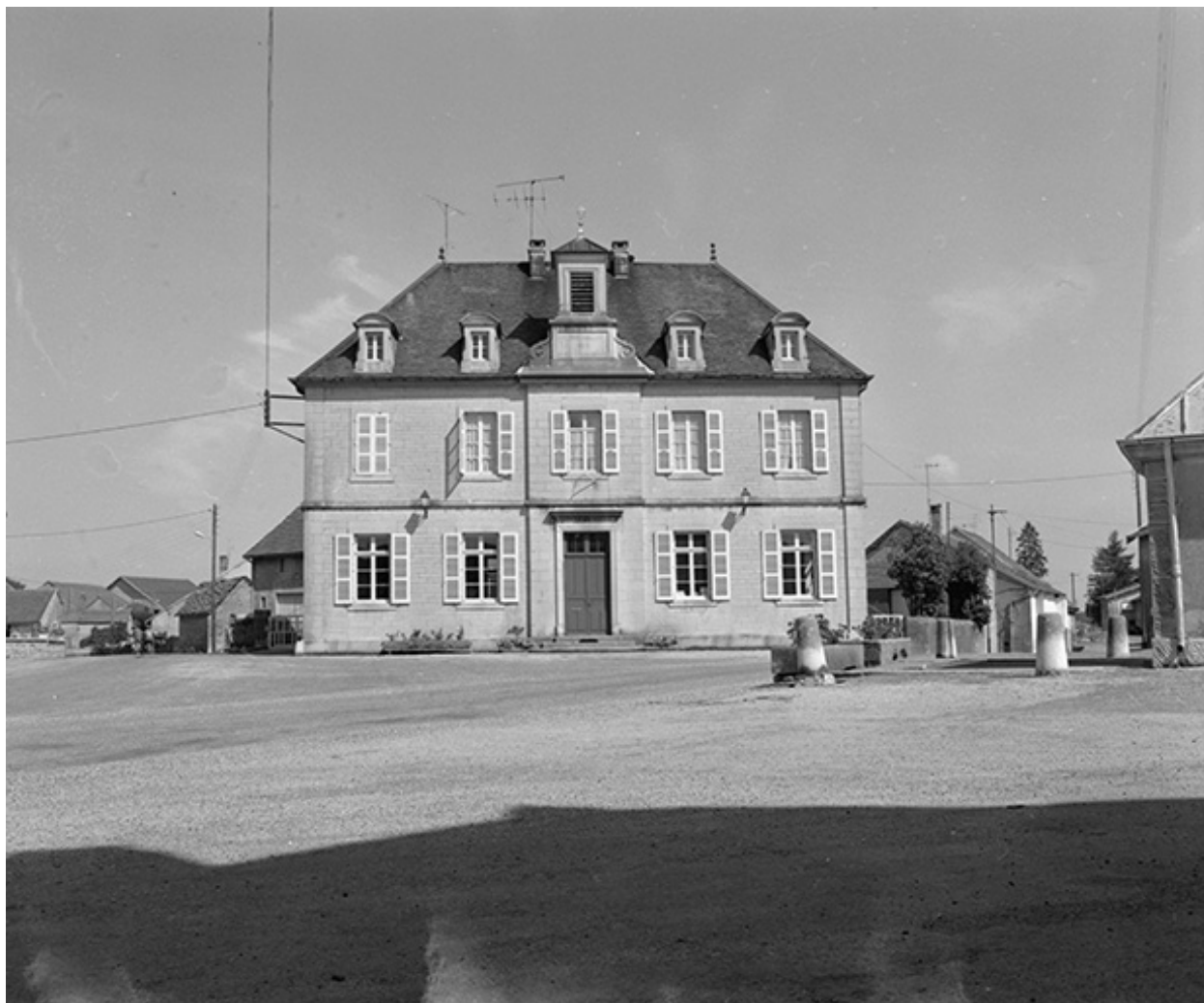
Façade antérieure vue depuis la rue.
