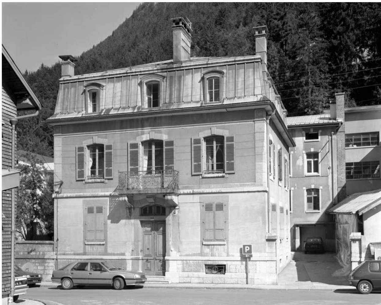
Site ancien : façade antérieure du logement.
