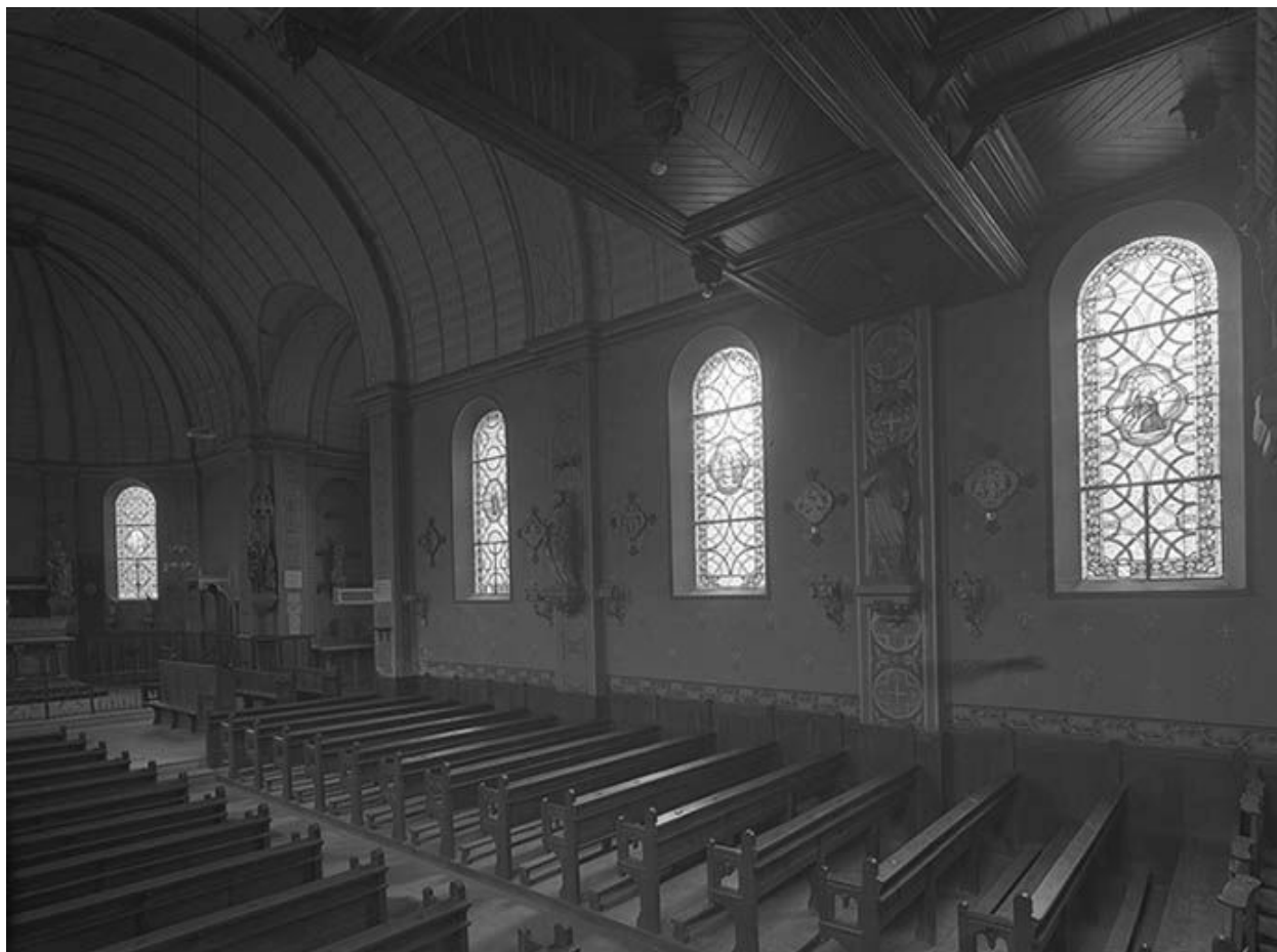
Vue sur le mur Sud.
