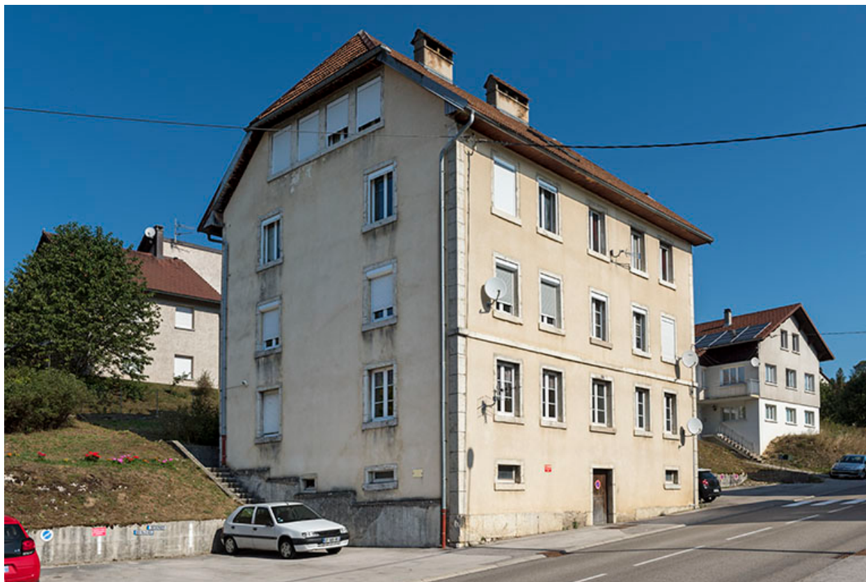
Façades antérieure et latérale gauche.
