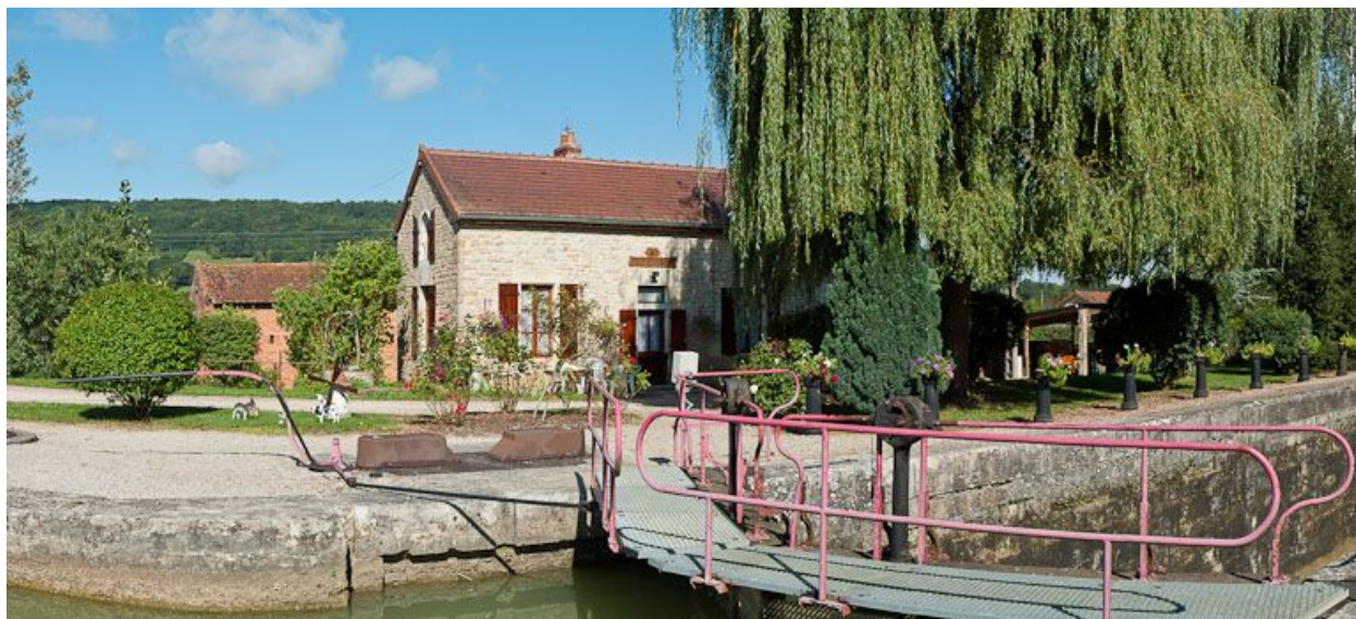
Vue du site d'écluse depuis l'amont.
