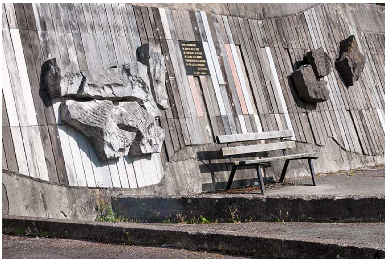
Vue de détail, depuis l'ouest.
