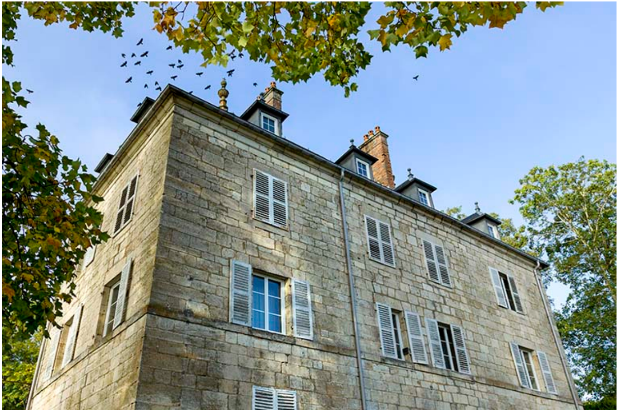
Façade postérieure et façade latérale droite.
