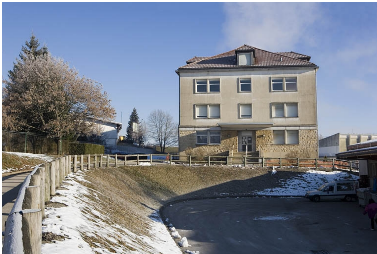
Site ancien, internat : mur pignon sud-ouest.
