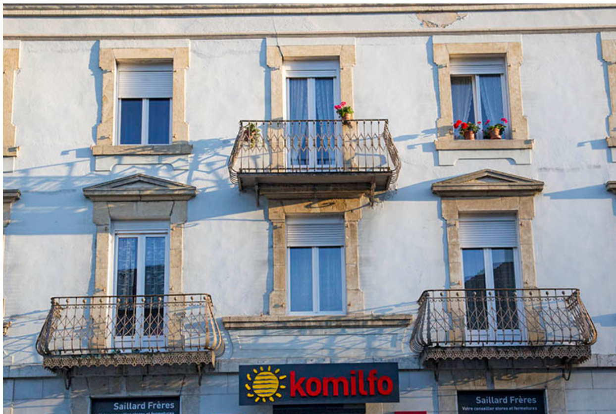
Immeuble au n° 11 : travées centrales.
