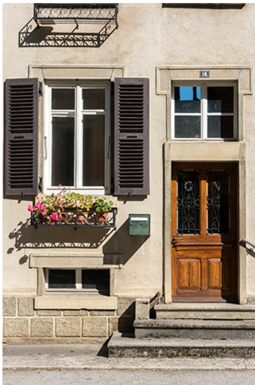
Façade antérieure : entrée et fenêtres.
