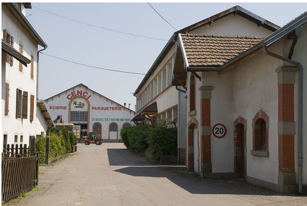
Vue d'ensemble depuis l'entrée.
