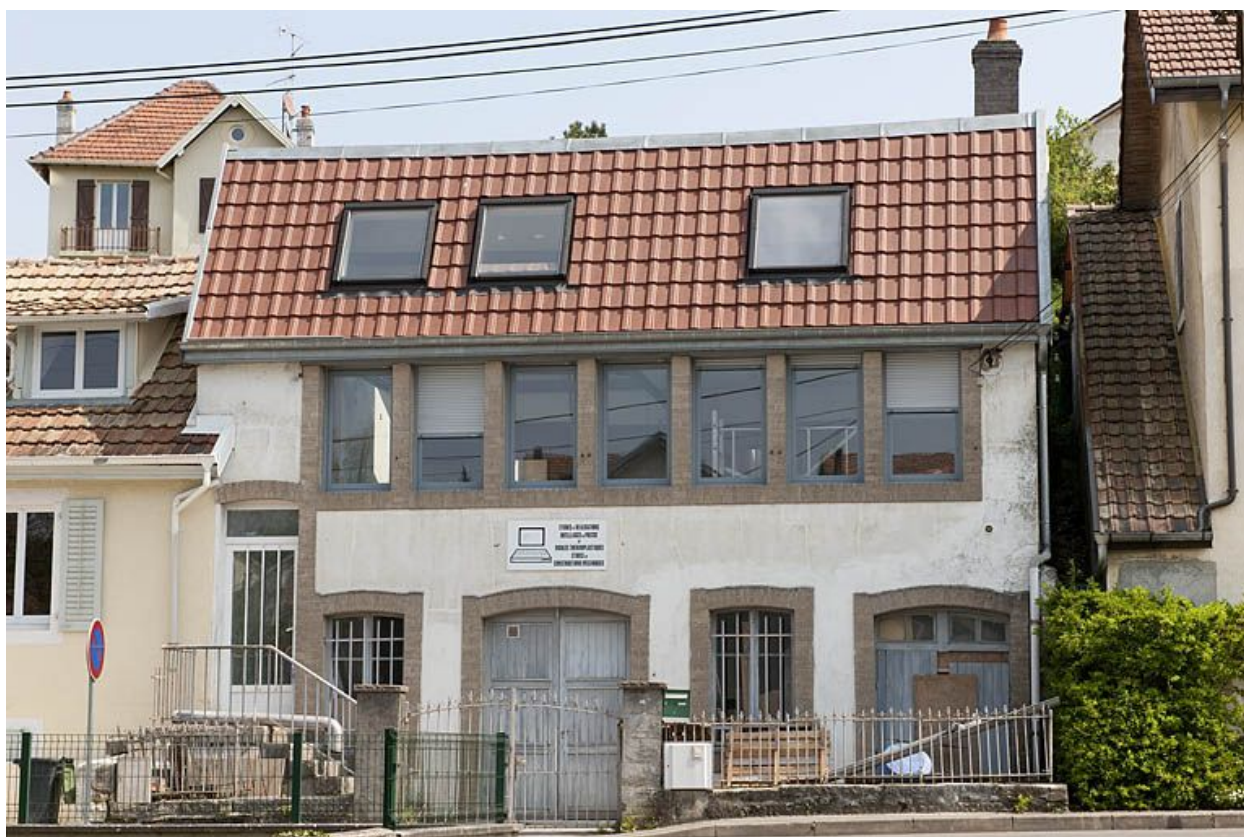
Façade ouest de l'atelier de fabrication.
