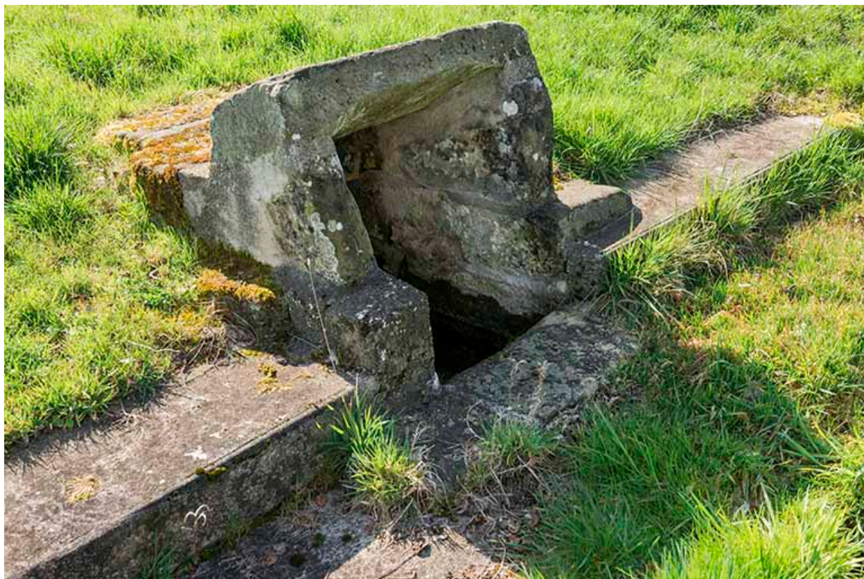
Fontaine d'alimentation du bassin.
