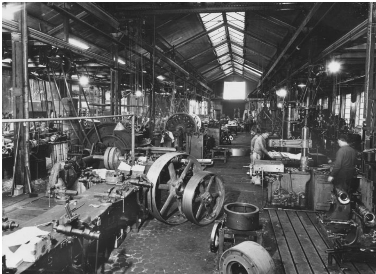
Vue intérieure d'un atelier de construction mécanique de l'usine Cuvier puis Wyss à Seloncourt. S.d. [milieu 20e siècle].
