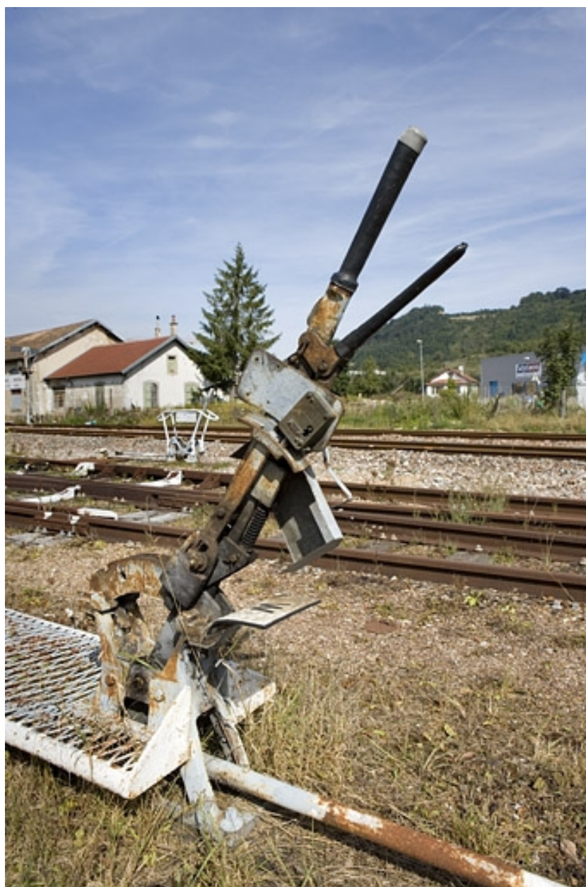
Levier de manoeuvre enclenché.
