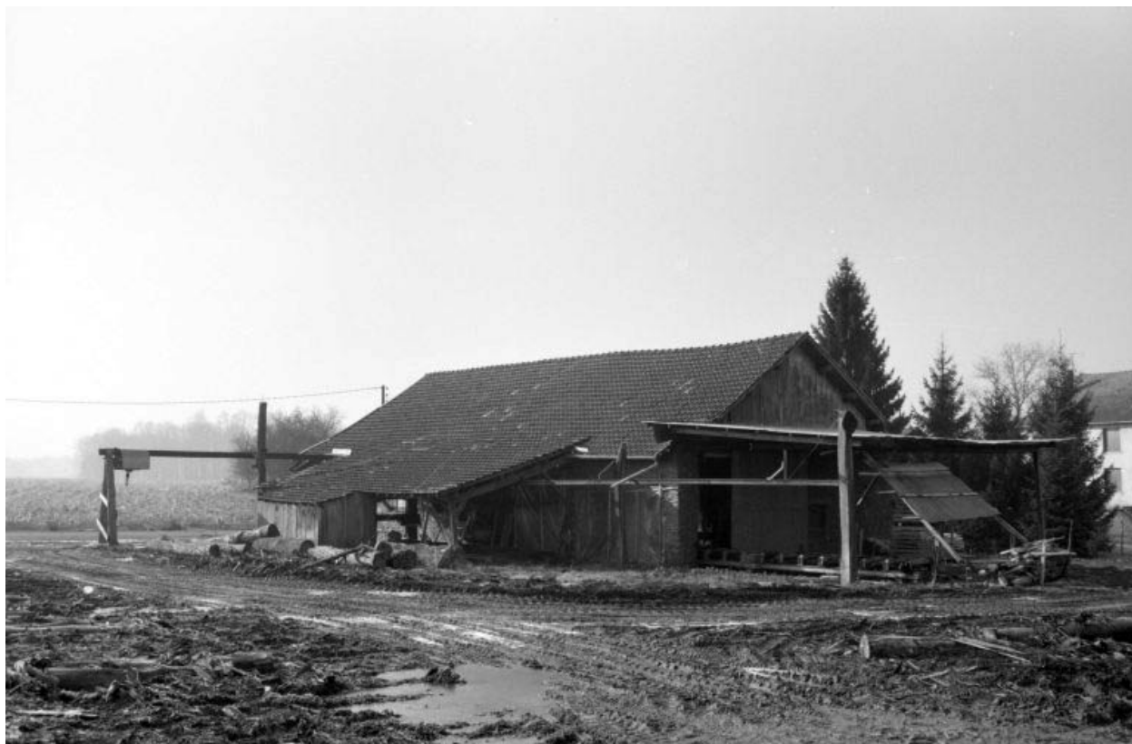
Atelier de fabrication, vu du nord-ouest.
