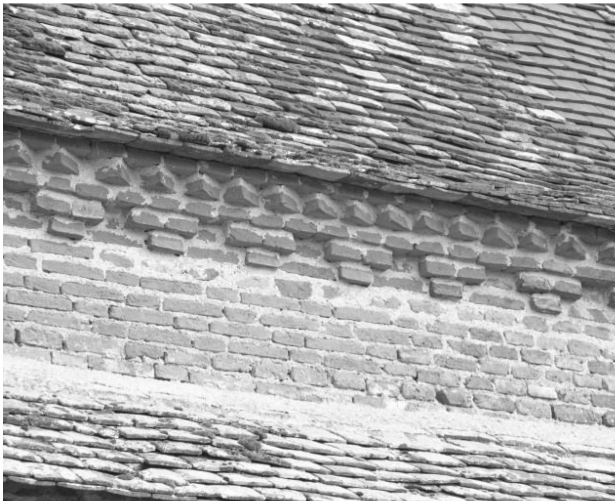
Détail de la corniche
