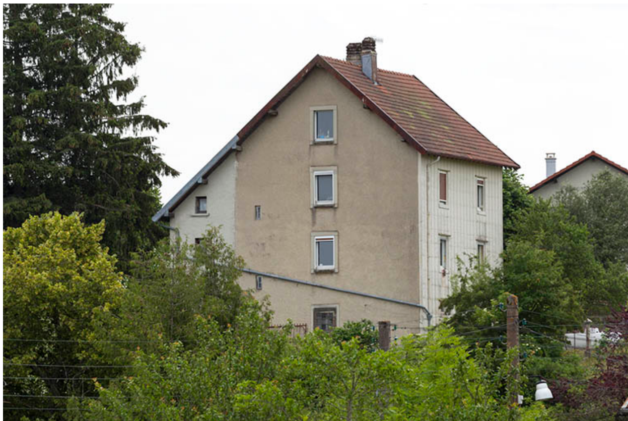
Façades postérieure et latérale gauche.
