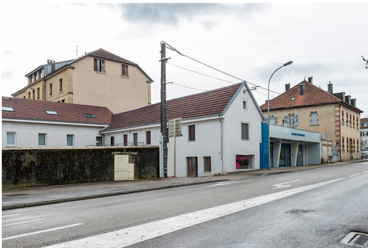
Vue d'ensemble depuis la rue du Mont.
