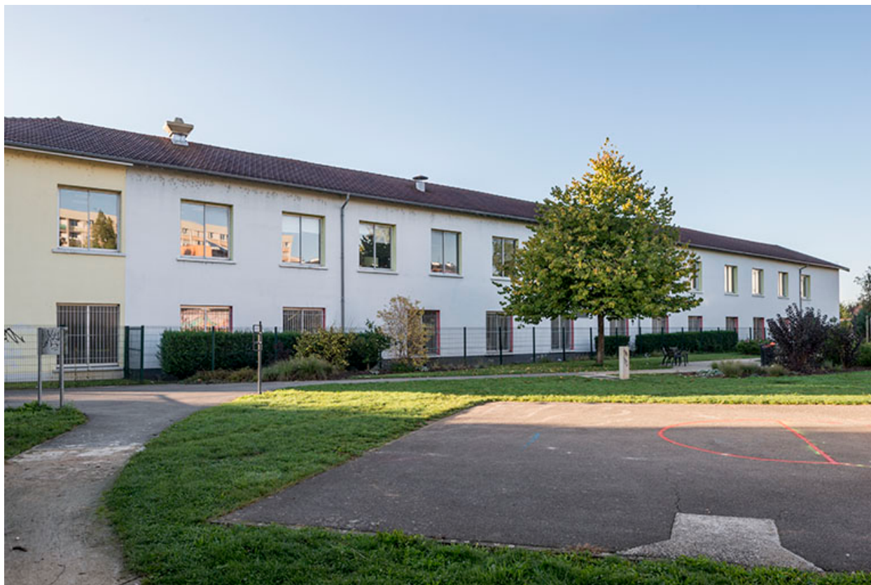
Façade nord de l'agrandissement (milieu 20e siècle).
