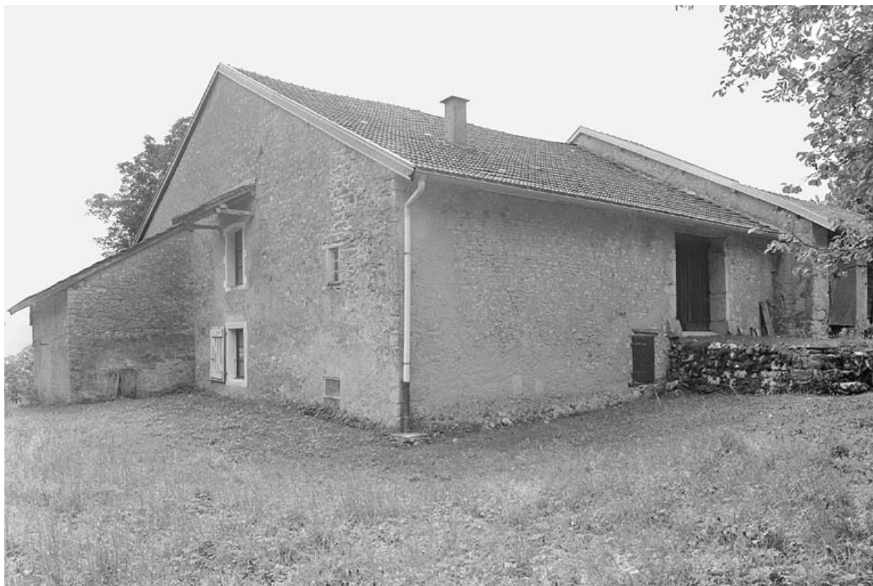
Face droite et façade postérieure.
