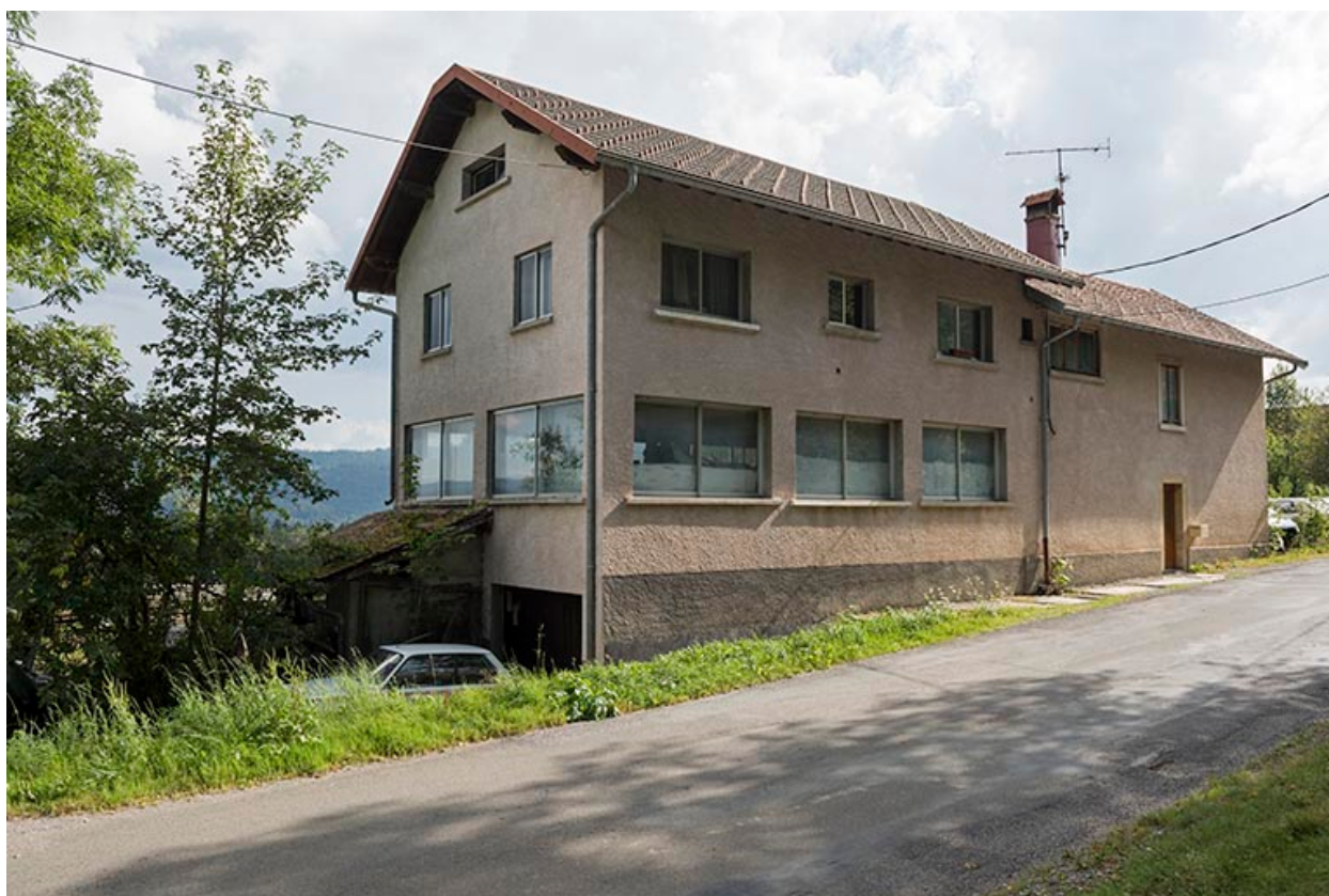
Façades antérieure et latérale gauche.
