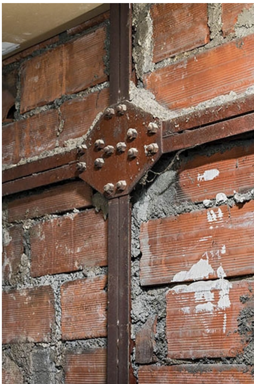
Détail du pan de fer d'un mur.
