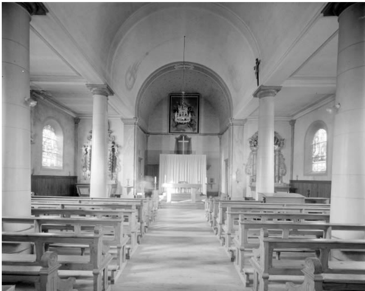
Intérieur : vue d'ensemble depuis l'entrée.
