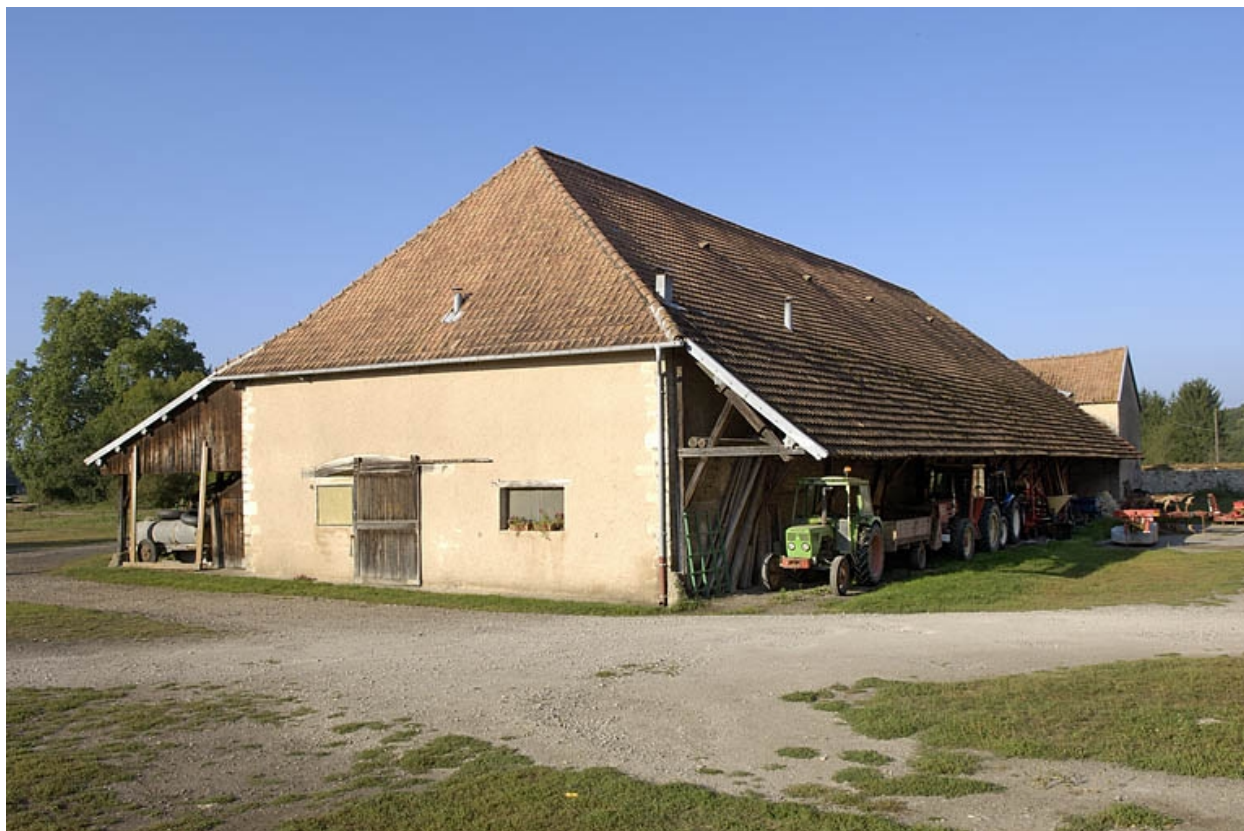
Halle à charbon vue de trois quarts.
