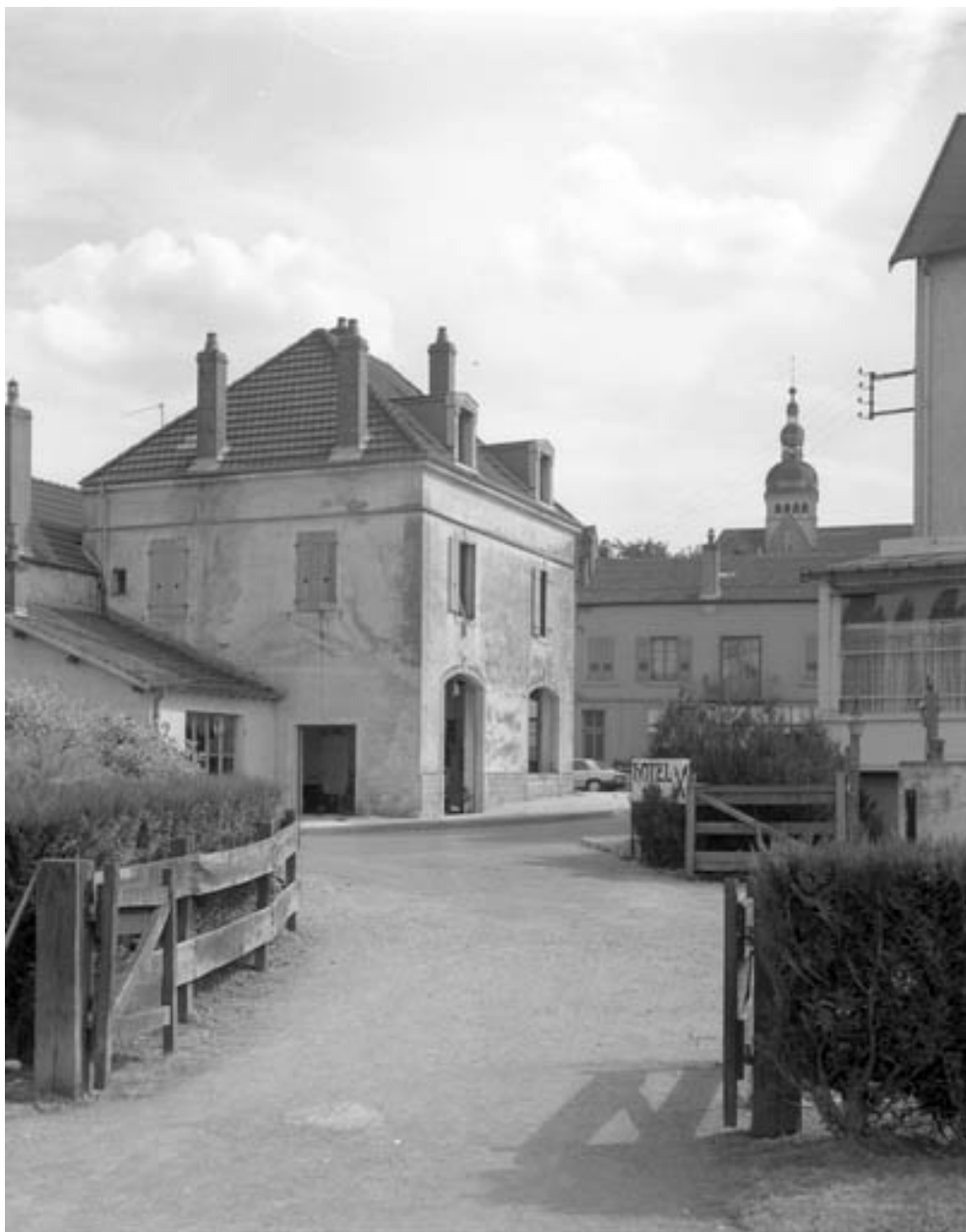
Façades postérieure et latérale gauche.
