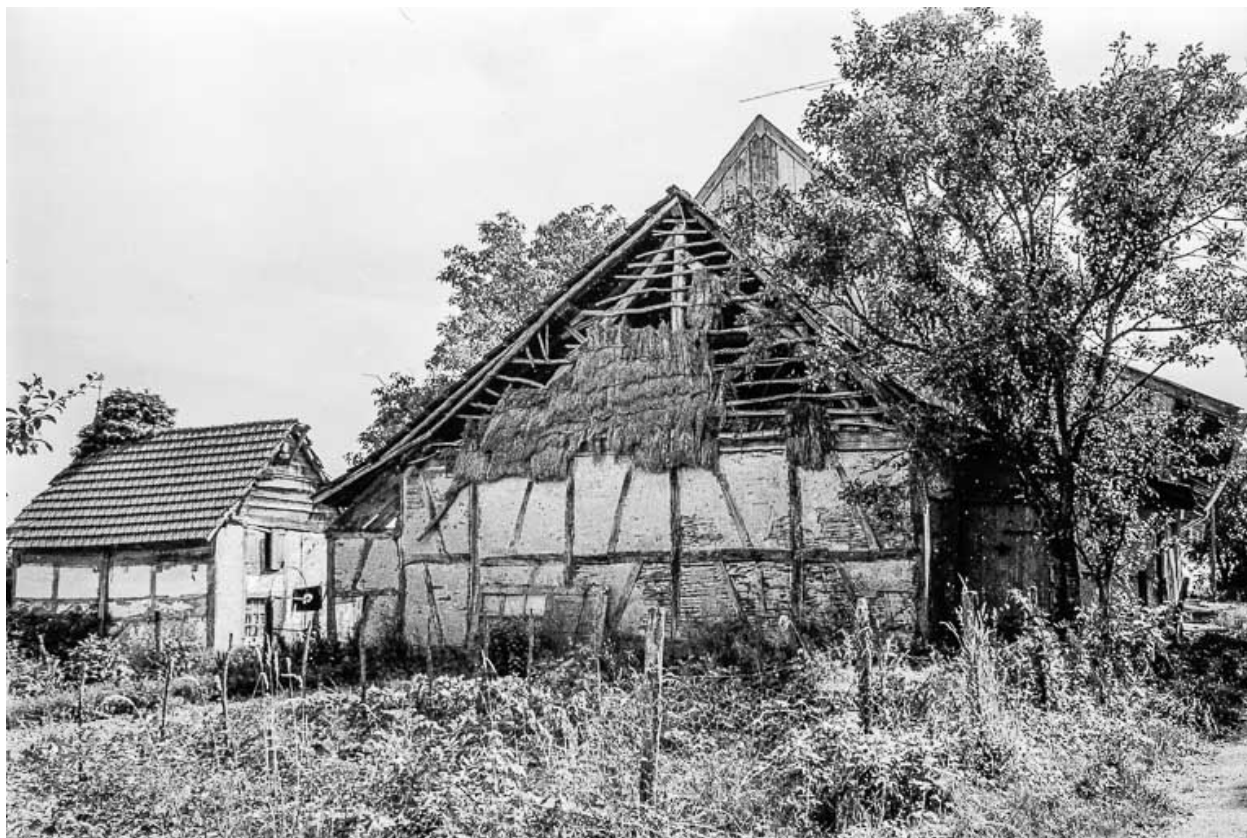
Pignon de ferme couvert en chaume.
