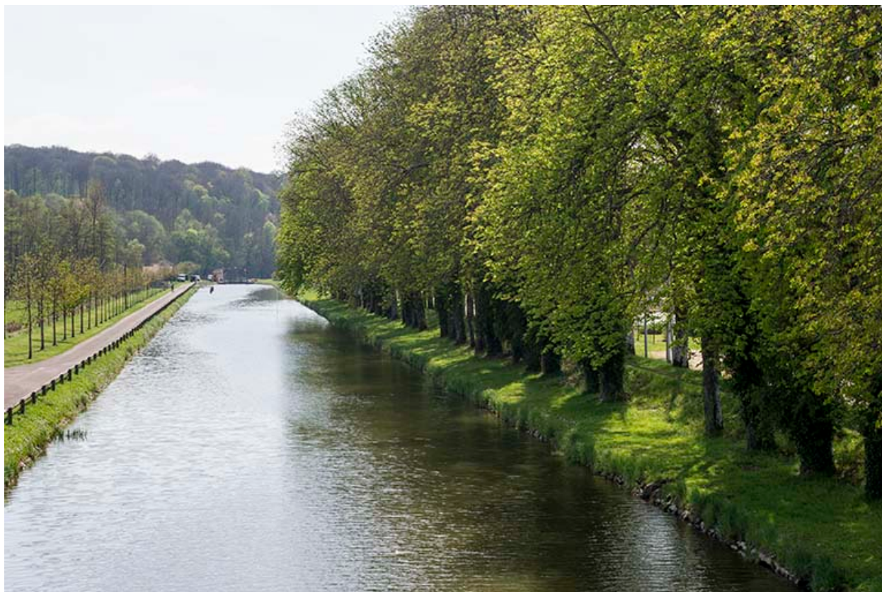
Vue générale du canal vers l'aval.
