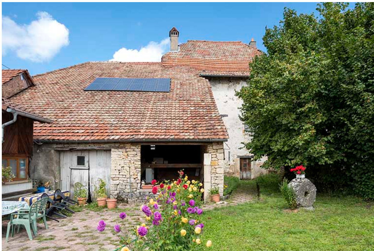
Maison et grange : façade postérieure.
