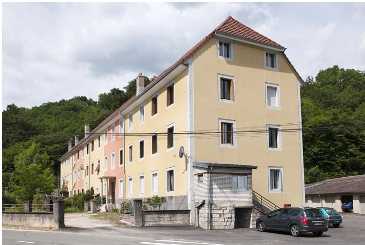
Façade sud vue de trois quarts.
