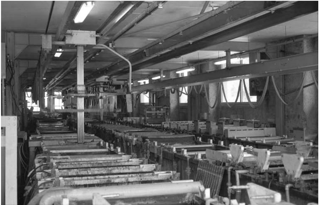
Intérieur de l'atelier de fabrication.
