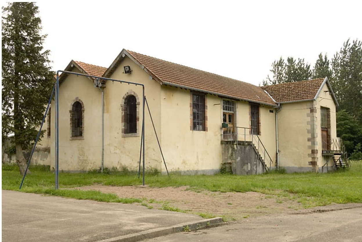
Centrale hydroélectrique. Vue de trois quarts.
