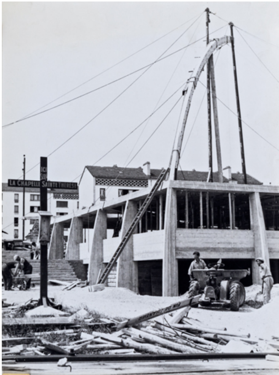
Église Sainte-Thérèse en construction, 1958.
