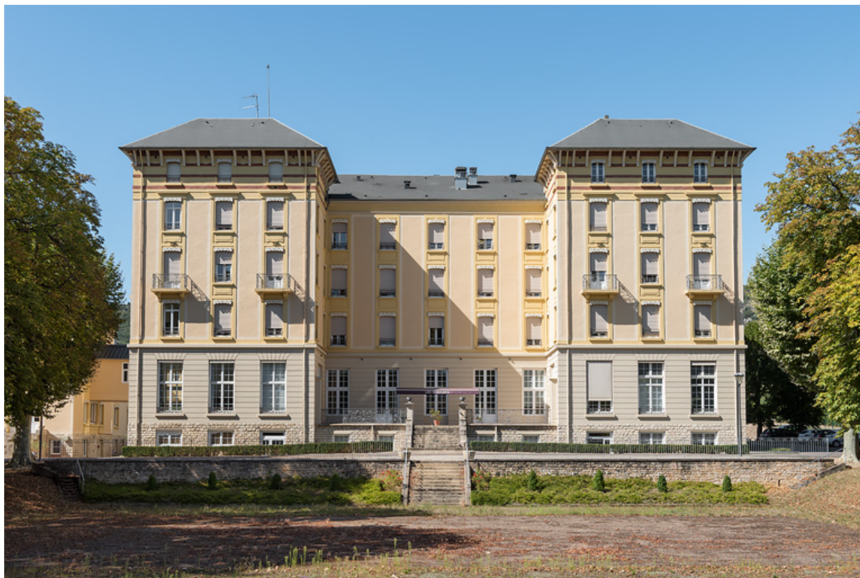
Façade principale sur le parc.
