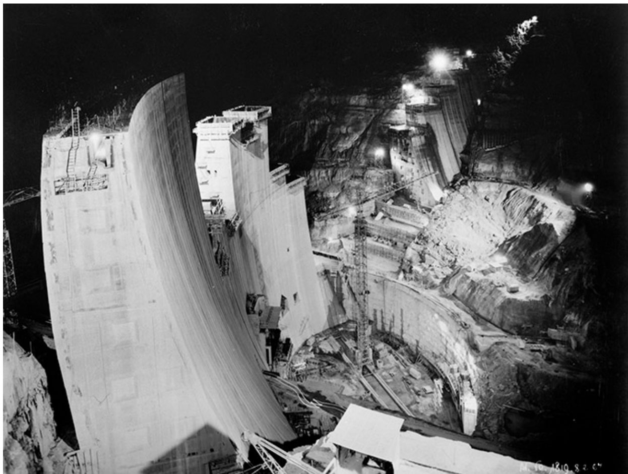
Barrage [de Vouglans] - Vue générale depuis R.D. aval des plots en cours de bétonnage (de nuit), 8 février 1967.
