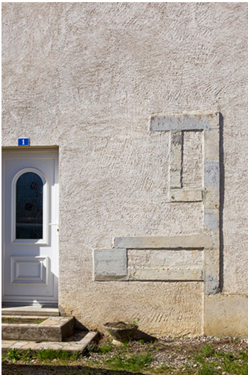
Façade postérieure : baies fromagères.
